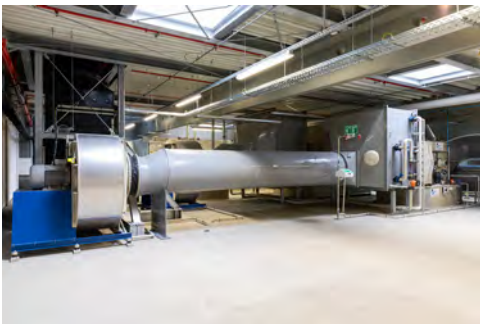
Abluftreinigungsanlage
