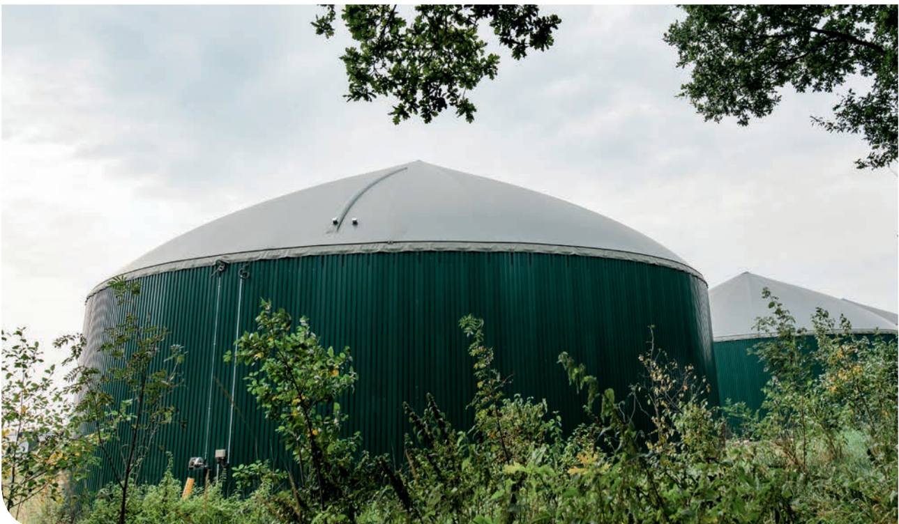
Externer Biogasreaktor – aus dem Blockheizkraftwerk zur Verstromung des Gases geht der Wärmeanteil in den Standort Varel
